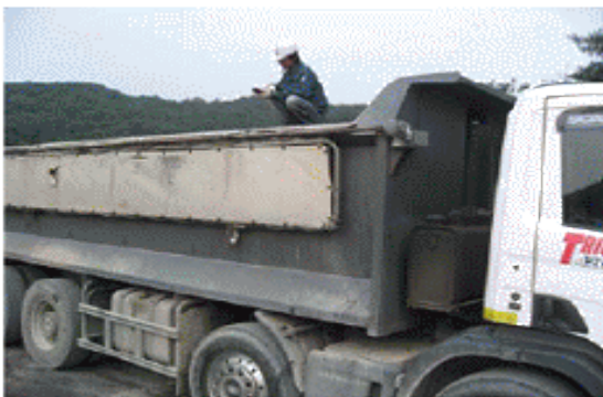
<그림 6.6> 운반 장비에 상차된 RPMA 혼합물의 온도 측정 전경
